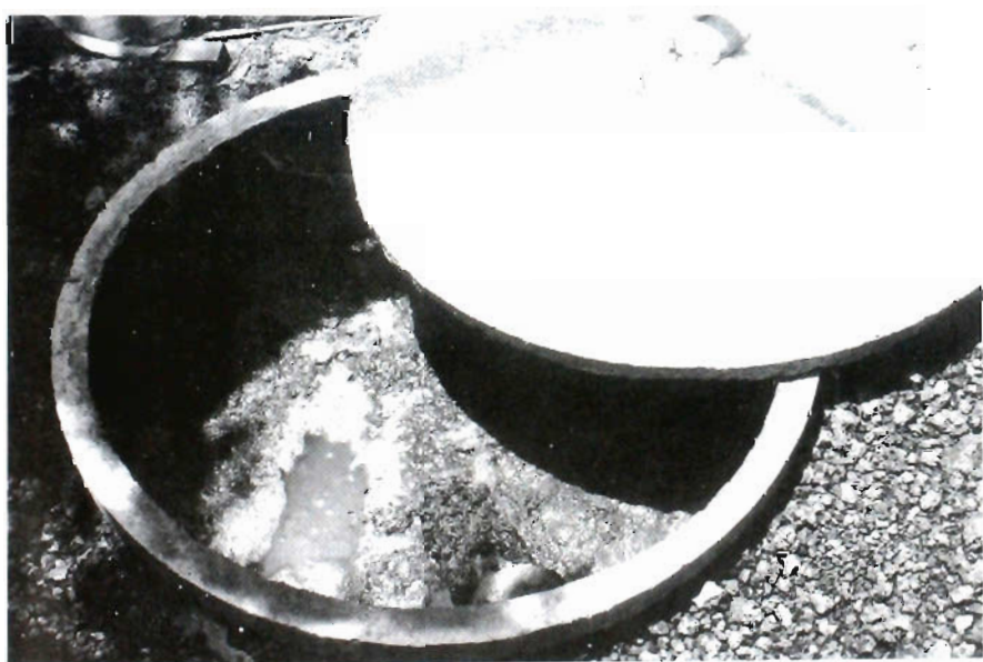
บ่อน้ำบาดน้ำเลียจากกระบวนการผลิตขมจีน ใช้มูลไก่มาช่วยในการทำให้เน่าตกตะกอน
